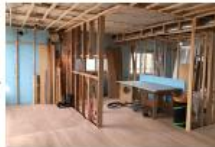
下地・断熱工事※2
