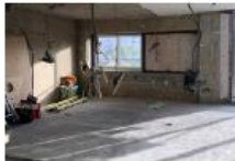
住戸内を解体※1
