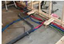
給排水管工事
