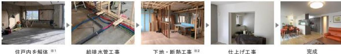
住戸内を解体 ※1 給排水管工事 下地・断熱工事 ※2 仕上げ工事 完成
