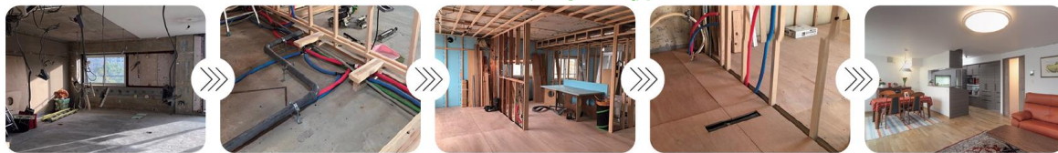
①住戸内を解体※1
