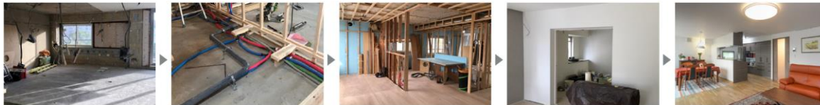
①住戸内を解体※1
