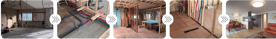
①住戸内を解体※1
