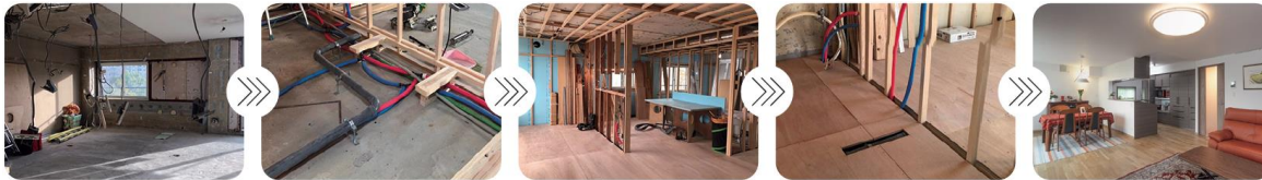
①住戸内を解体※1
