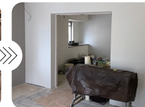
④仕上げ工事
