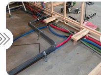
②給排水管工事
