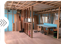
③下地・断熱工事※2
