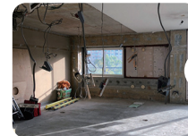
①住戸内を解体※1
