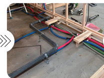
②給排水管工事
