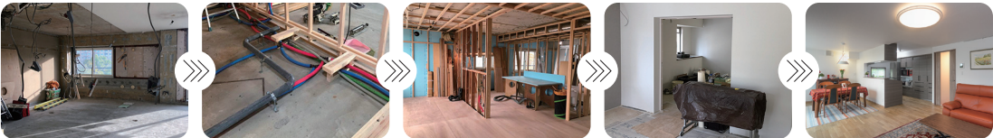
①住戸内を解体※1 ②給排水管工事 ③下地・断熱工事※2 ④仕上げ工事 ⑤完成
