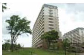
▲ビーコンヒル能見台サウスビル（神奈川県）
