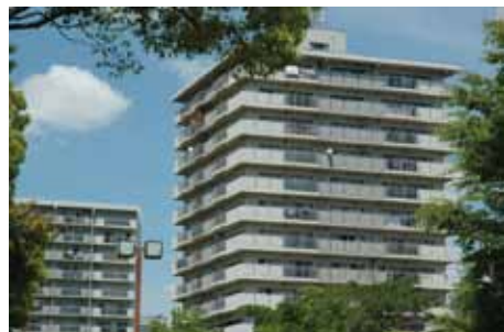
■ゆったりと広い空間を挟んで、高層住宅が並ぶ六野地区。
