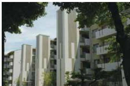
■昨年秋、三本松地区の5階建て3棟に設置した“踊り場着床型のエレベーター”。
