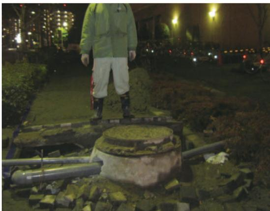
◀震災直後、仮設排水管を設置するために夜間も突貫工事が続く。
