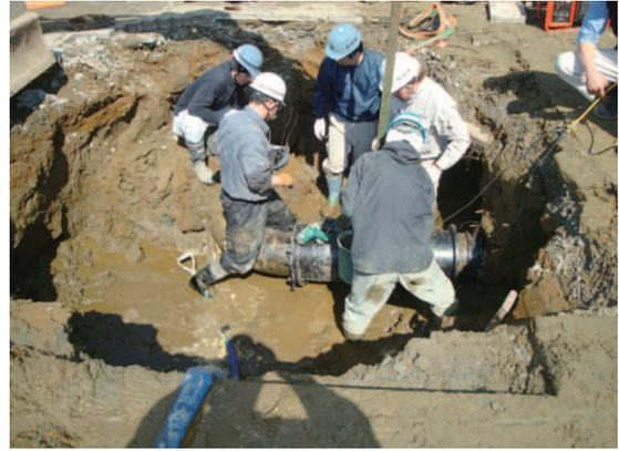
◀中に埋められた太い給水管の漏水箇所を修理・復旧させる技術スタッフたち。
