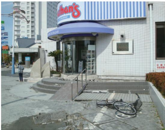
◀残された震災のつめあと。階段の一部が崩れ、タイヤ張りの路面が地震によって無惨に盛り上がる。
