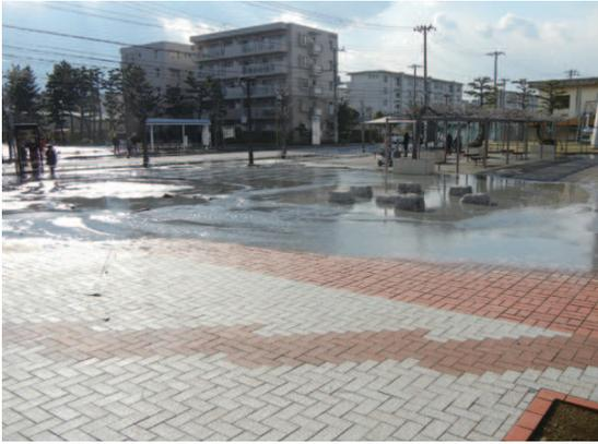
◀震災直後、給水管が破損して多数箇所でも漏水し、大量の水が漏れ出す。
