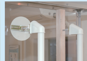
▲下地が石膏ボードと木軸の場合の取り付け方
