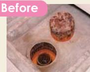
▲ 古くなった浴室の排水トラップを交換せずに、補修し生き返らせる「浴室排水トラップ改修」。
