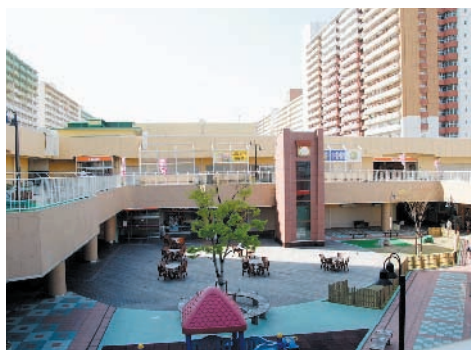
▲西宮市高須町にある武庫川団地。地上1～2階部分にショッピングセンター「メルカードむこがわ」があり、スーパーマーケットや飲食店など59店舗が入店しています。
