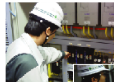
▲制御盤の電気回路の点検
