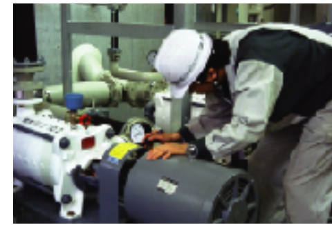
▲給水ポンプの点検
