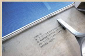
建物の各所に使用している建築材料や寸法、仕上げ方法等を表示
