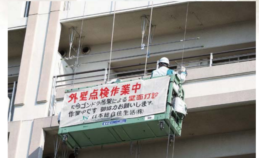
外壁点検作業
