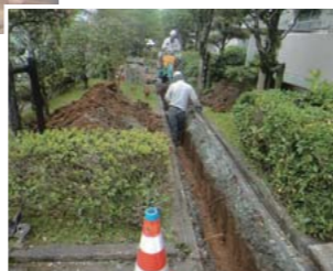
屋外配管工事
