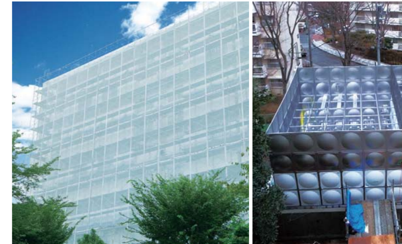
大規模修繕工事
