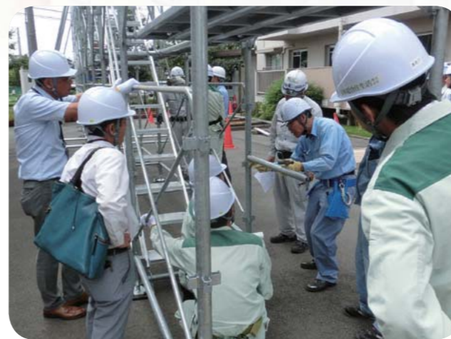
仮設足場の組立・解体の実習
