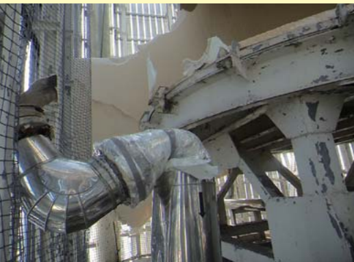
高置水槽及び周辺配管破損状況
