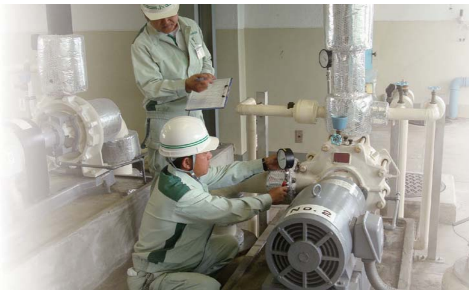
給水設備の点検
