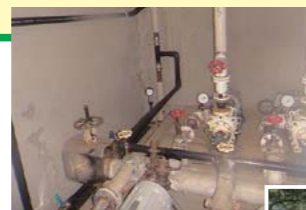
ポンプ室内仮設配管工事
