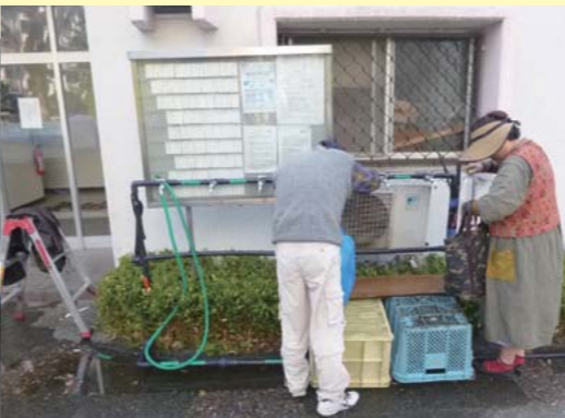
仮設給水装置の設置
