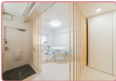
ルーバーを動かし、 団らんの空間とつながっている様子
