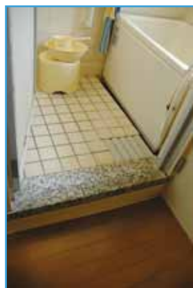
◀浴室床のかさ上げ 浴室の床を5cmかさ上げて段差を軽減。浴室や浴槽への出入りがスムーズに。
