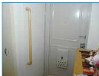
◀玄関の手すり 玄関に取り付けた、握りやすく手触りの良い木製手すり。出入りが楽に安全に。
