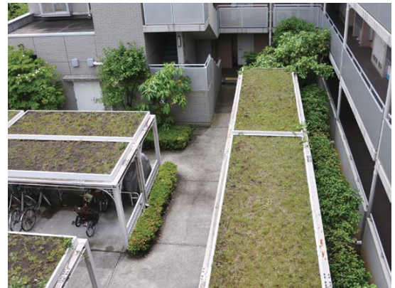
▶ 自転車置場の屋上緑化
