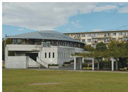
■豊明団地自治会が管理をしている 自治センターは豊明団地の中心。
