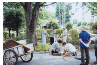
■汚水マスを使った非常時の簡易トイレを点検中。
