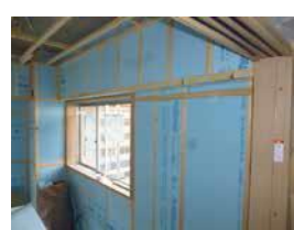
壁断熱工事
